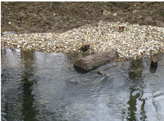
Bauweisen sind gesichert mit Stahlseil und Holzpfehlen (2013)
