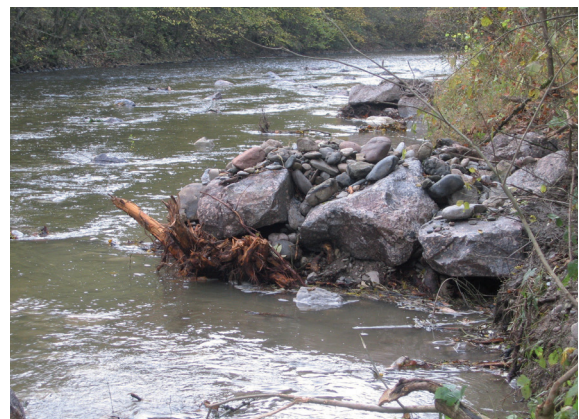
Wurzelstock durch Steinauflage gesichert
