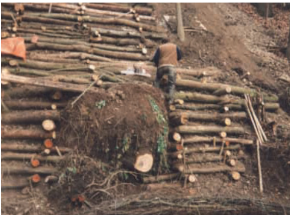
Einbindung eines gefällten Baumes
