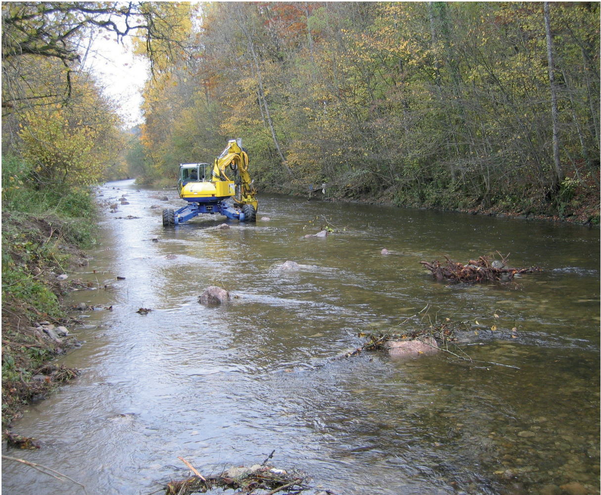
Einbau der Strukturelemente
