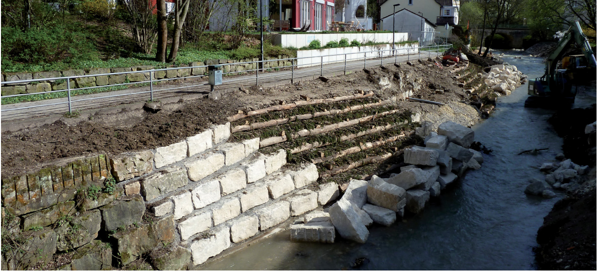
Fertiggestellte Krainerwand und Blocksteinmauer
