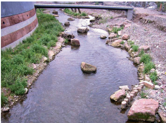
Naturnah gestaltetes Niedrigwasserbett mit Senkfaschinen und Pfahlbuhnen (2005)
