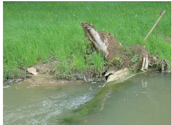
Baumstamm mit Wurzelstock als Leitbuhne (2003)
