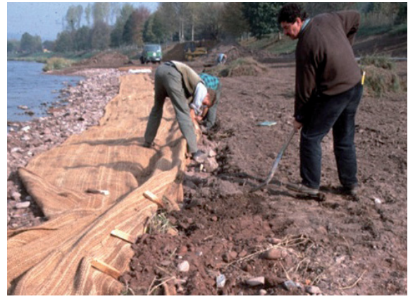
Bau 1990: eingelegte Soden, Verschließen des Gewebes
