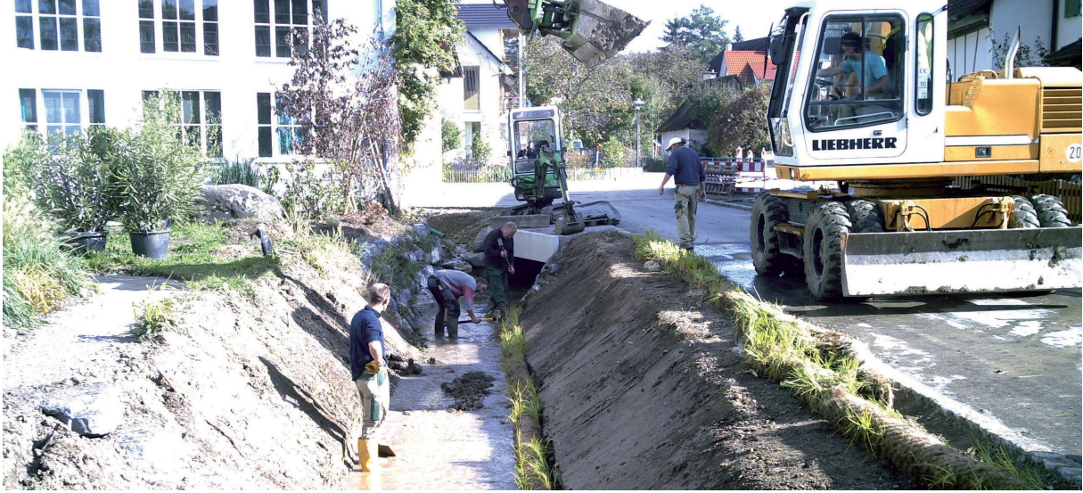
Einbau der Vegetationswalzen am Böschungsfuß
