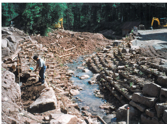
Bauausführung ingenieurbiologischer Bauweisen
