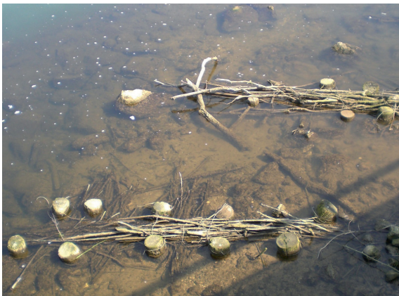
Lahnungen mit Sedimentationswirkung nach 2 Jahren
