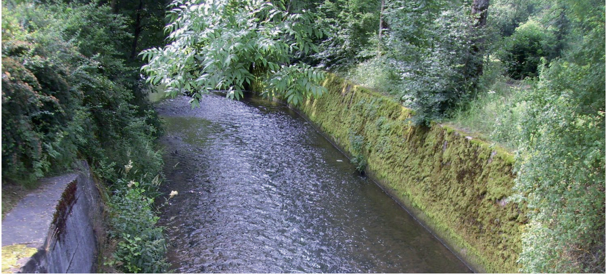
Bestand vor der Umgestaltungsmaßnahme: Naturferne Ufermauern und Sohlschwelen (Juni 2009)
