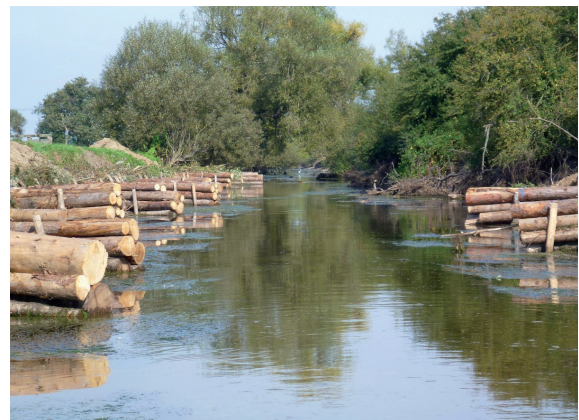
Eingebaute Ausfachungsbuhnen während des Bachabschlags
