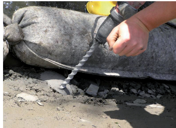
Vorbohren zum Setzen der Stahlnägel
