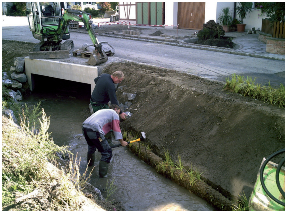
Sicherung der Vegetationswalzen
