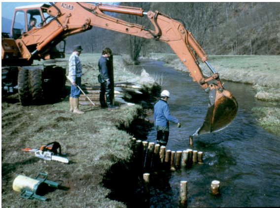
Einbringen der ca. 1,50 m langen Holzpfähle
