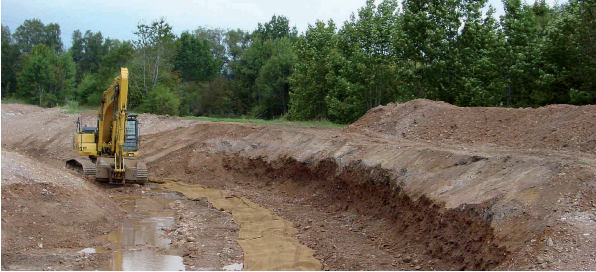
Vorbereitung für die unterste Lage der Geotextilfaschine (2012)
