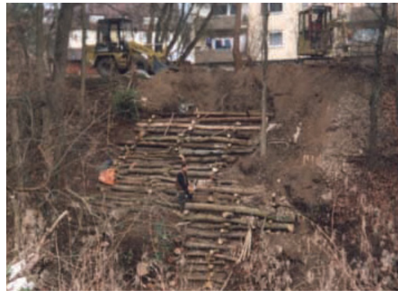
Wiederherstellung des Ufers mittels Krainerwand
