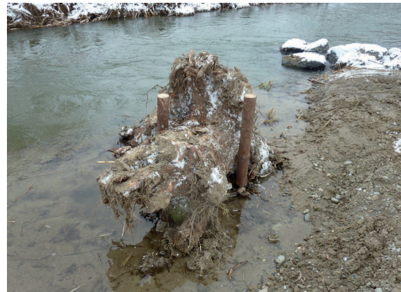
Mit Pfählen befestigter Wurzelstock (2010)
