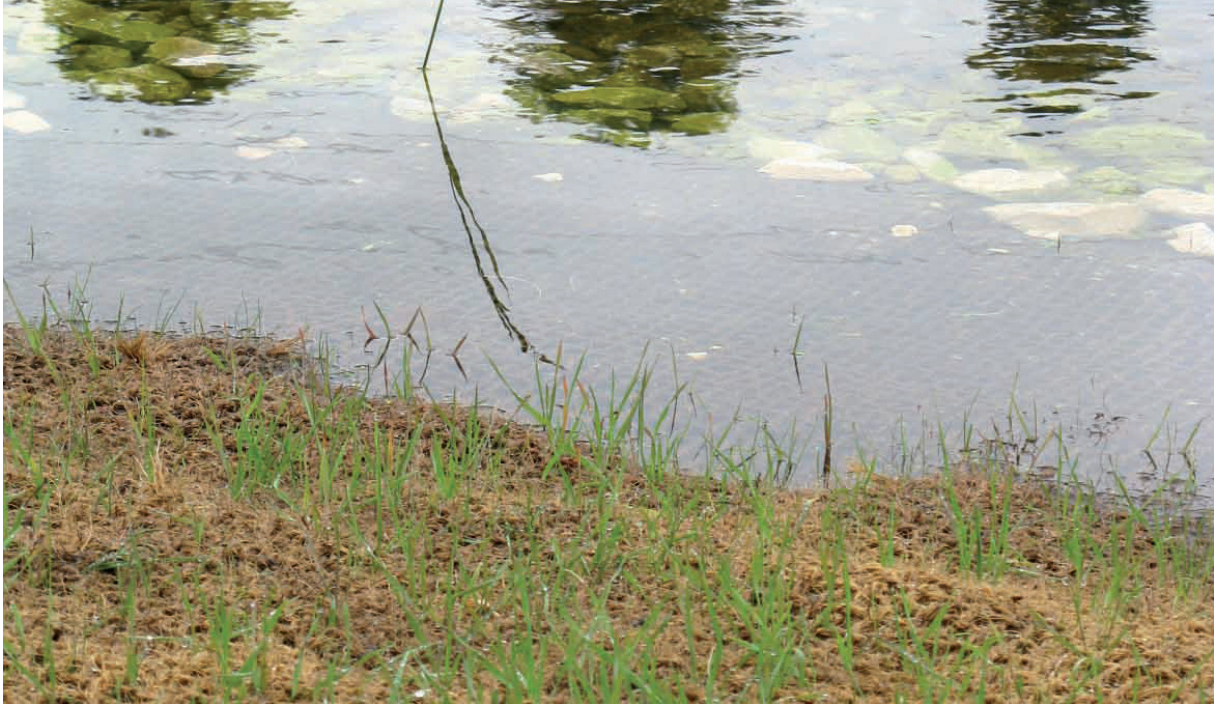
Kokosgewebe 700g/m 2 mit erstem Austrieb
