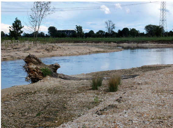
bei MW wird das Leitwerk überströmt
