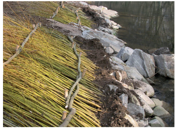
Detail der Spreitlage nach Fertigstellung
