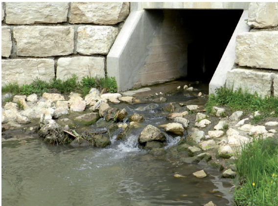
Umbau mit aufgeweiteter Mündung und verkürztem Durchlass (2010)
