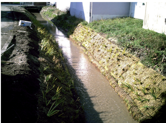
Böschungssicherung durch Naturtextil mit Röhricht
