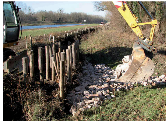
Einbau Wasserbausteine 10-20 kg als Kolksschutz
