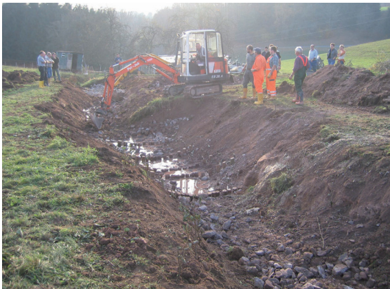
Sohlaufhöhung und Aufweitung mit unterschiedlichen Bauweisen
