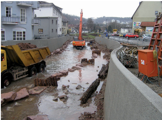
Einbau von Pfahlbuhnen (2004) (I)
