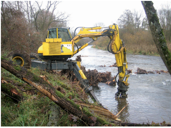
Einbau der Wurzelstöcke mittels Schreitbagger mit Bohraufsatz (2006)
