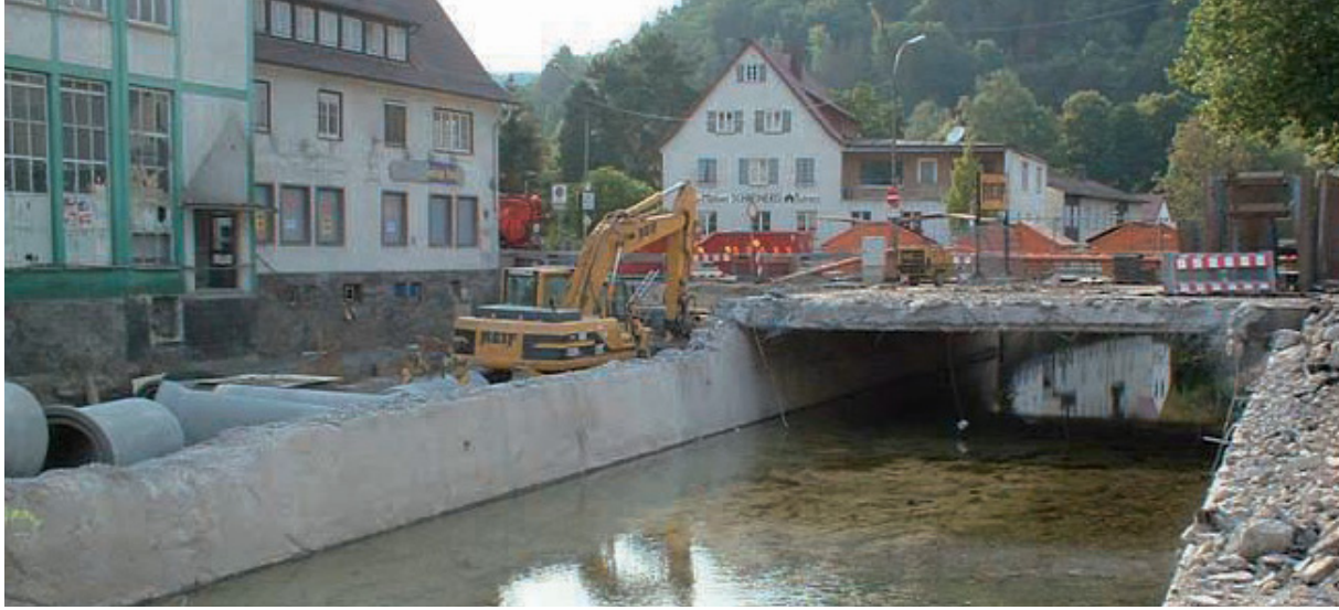
Abbruch der Betonplatte über der verdolten Waldach (2004)
