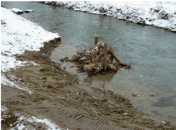
Ufermodellierung und Einbau der Wurzelstöcke (2010)
