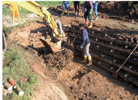
Einbau der Wurzelstöcke
