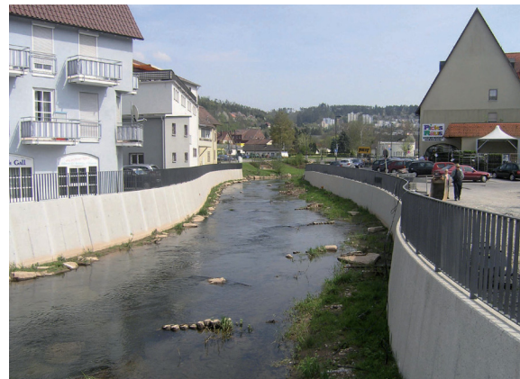
Pfahlbuhnen mit dahinterliegenden Totholzfascinen und Vegetationswalzen (2006) (III)
