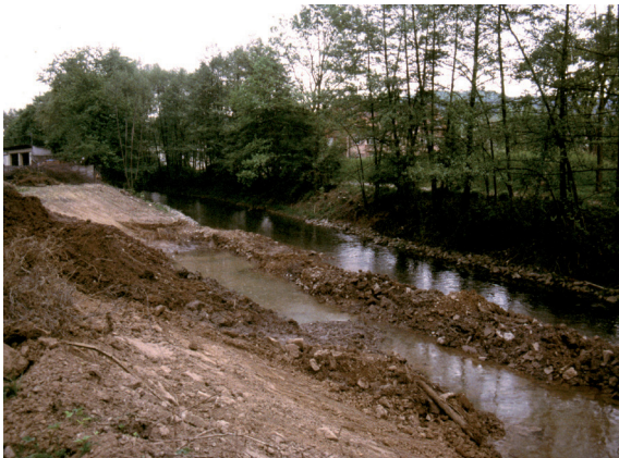
Erdarbeiten zur Gewässeraufweitung
