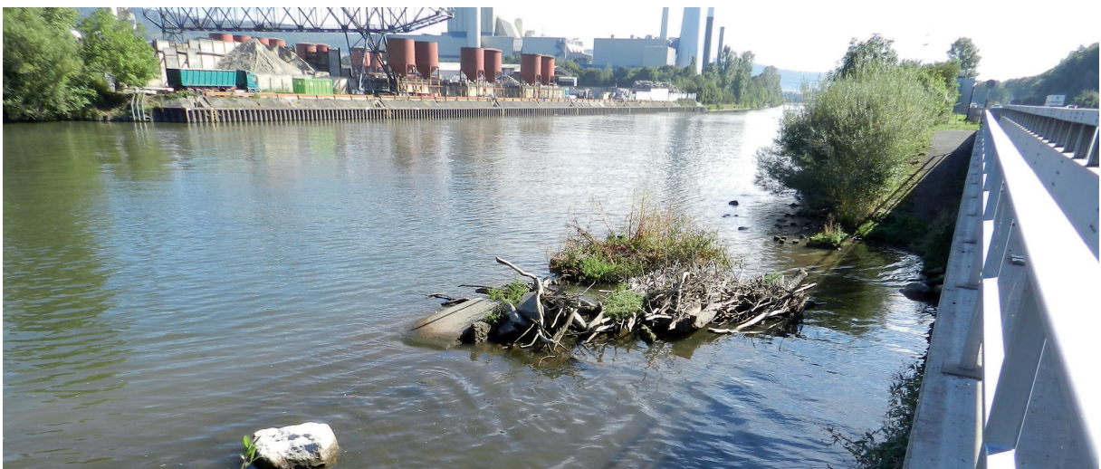
Entwickelte Lahnungen nach 6 Jahren (2012)
