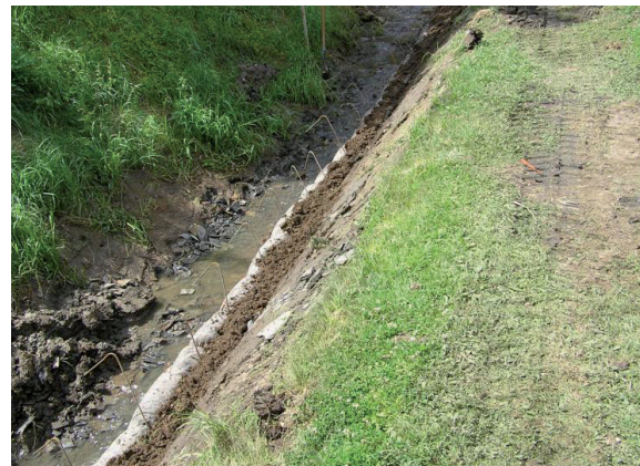
Übererdung und Modellierung des Ufers
