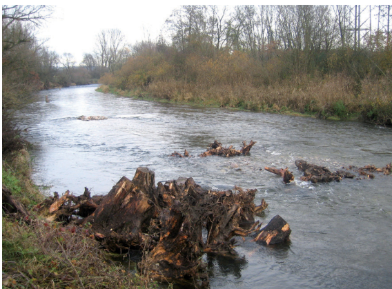
Eingebaute Wurzelstockbuhnen (2006)
