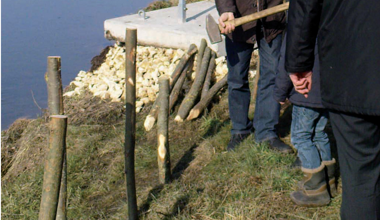
Einschlagen der Setzstangen mit dem Vorschlaghammer (2011)
