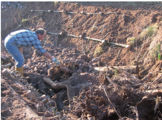
Sohlstabilisierung mit Wurzelstöcken
