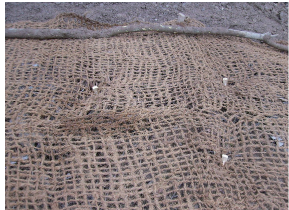
mit Böschungsnägeln aus Holz befestigte Erosionsschutzmatten (Oktober 2010)
