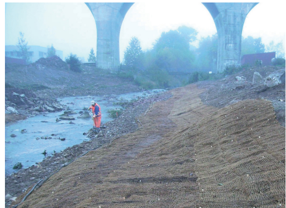
Einbau Erosionsschutzmatten (Oktober 2010)
