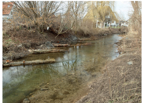
Nach Einbau der Strömungslenker und Vorlandabtrag
