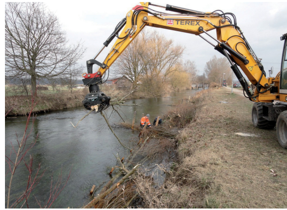
Bauphase 1, Einbau der Buhnen
