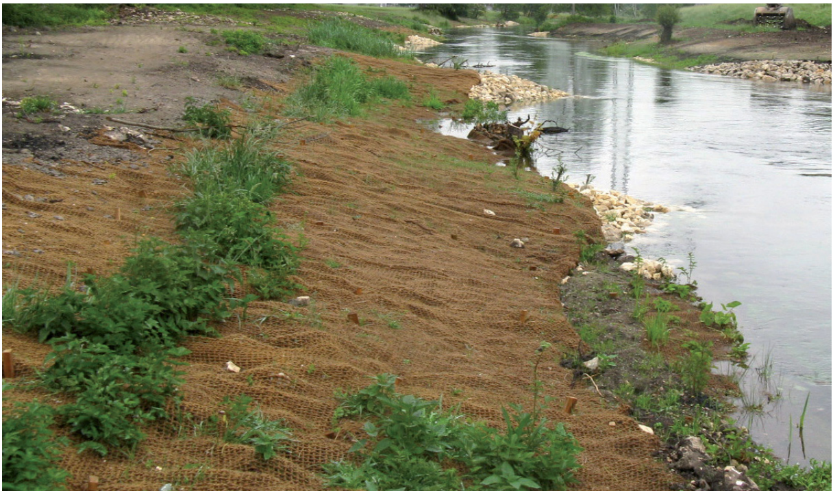
Punktueeller Austrieb nach 8 Wochen mit auflaufender Saat
