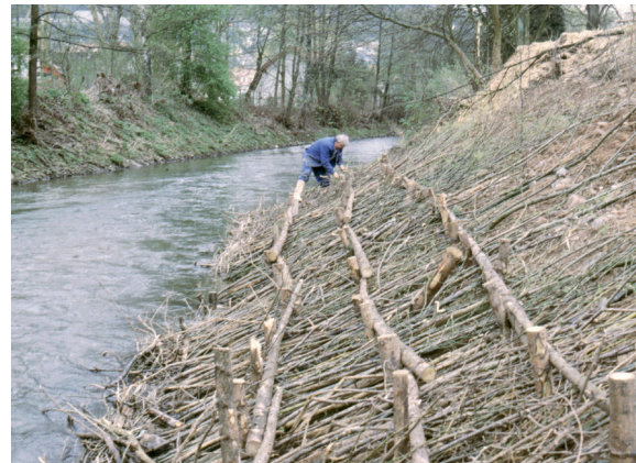
Befestigung der Fichtenstangen an den Pfählen
