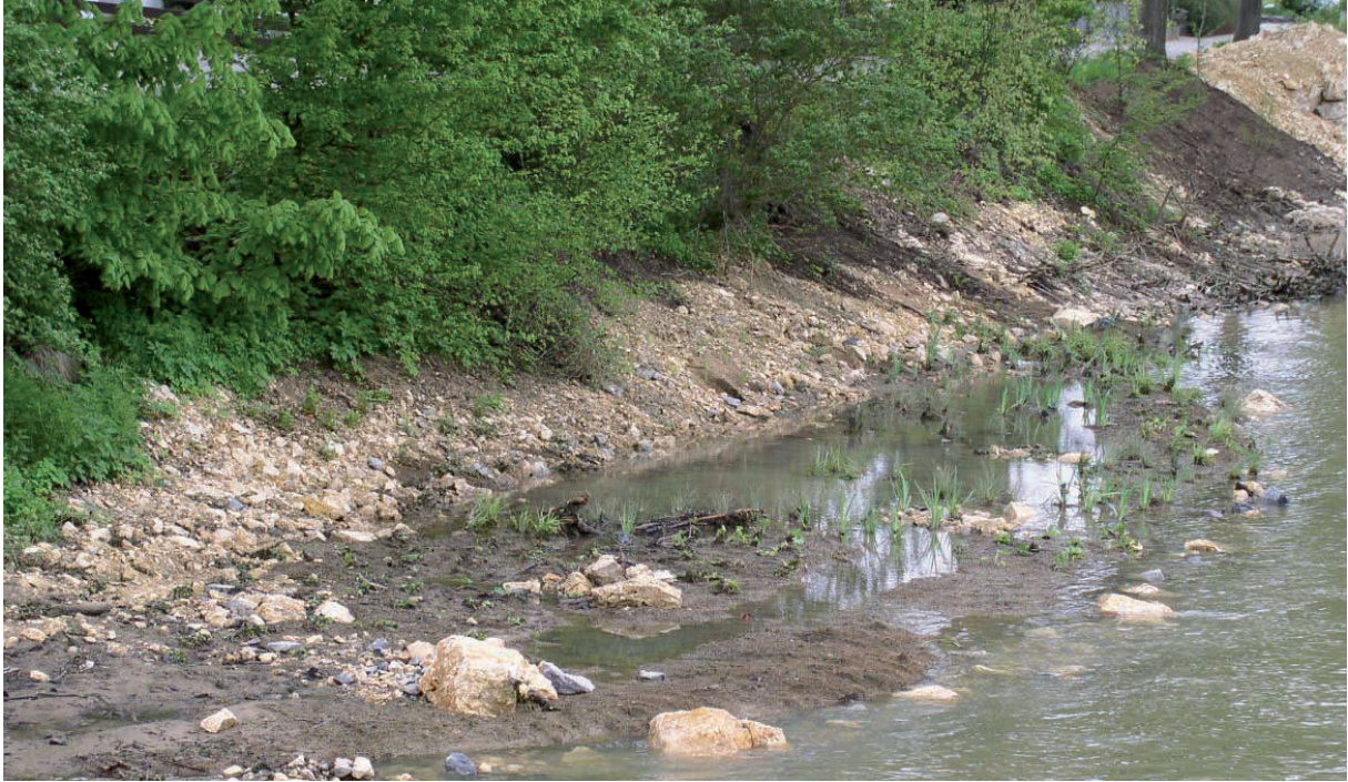
Eingebaute Vegetationswalzen unmittelbar nach Fertigstellung (2004)
