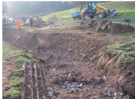
Überschüttete Wurzelstöcke (im Vordergrund)
