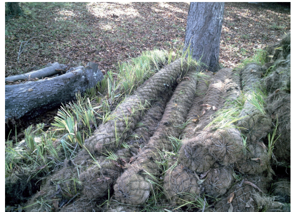
Vegetationswalzen vor dem Einbau
