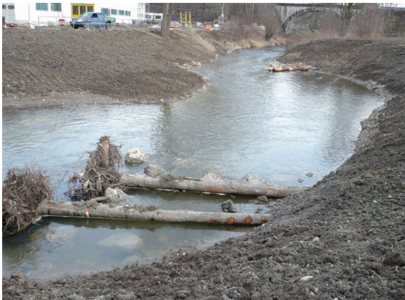
Fertig gestellte Wurzelbaumbuhnen (2010)
