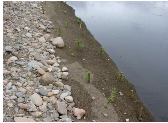
Eingebaute Geotextilfaschine mit Weidenstecklingen (2013)
