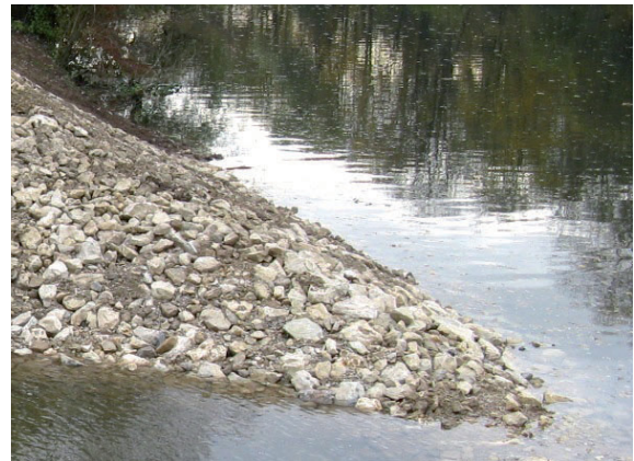
Böschungssporn zum Neckar mit Steinwurf LMB 5/40, Weidensteckhölzern (8 St/m 2 ) und Überkiesung mit 0-80 Gemisch
