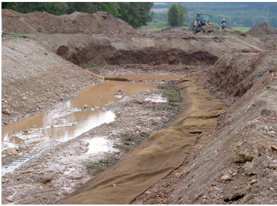
Die unterste Geotextilfaschine wird gefüllt und umgeschlagen
