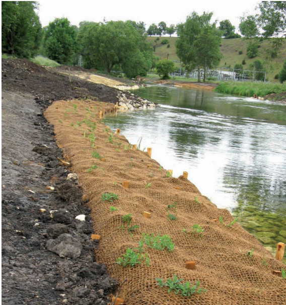
Punktueeller Austrieb der eingebauten Pflanzensoden nach 4 Wochen
