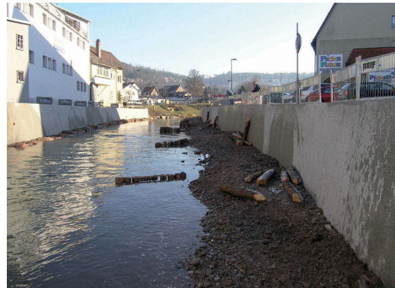
Fertiggestellte Pfahlbuhnen zur Strömungslenkung (2005) (II)
