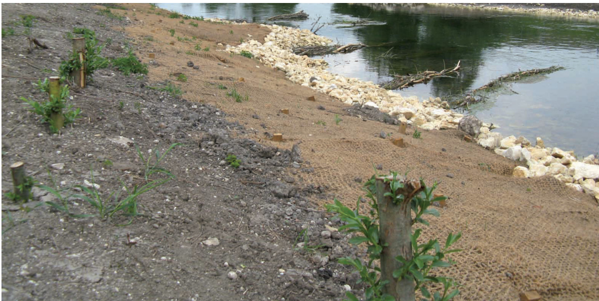
Austrieb der Setzstangen nach 8 Wochen
